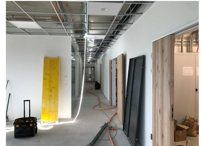
Foto aus Progress Report Nr. 21
