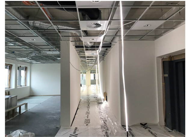
Foto aus Progress Report Nr. 21
