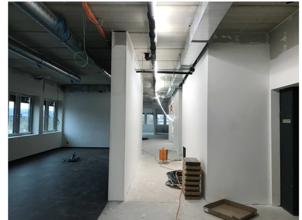
Foto aus Progress Report Nr. 19
