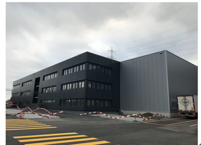
Foto aus Progress Report Nr. 19
