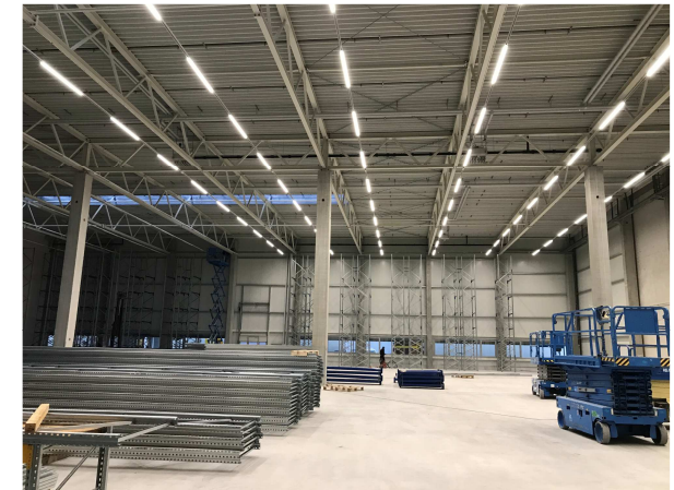
Foto aus Progress Report Nr. 19
