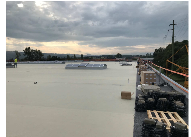
Foto aus Progress Report Nr. 12
